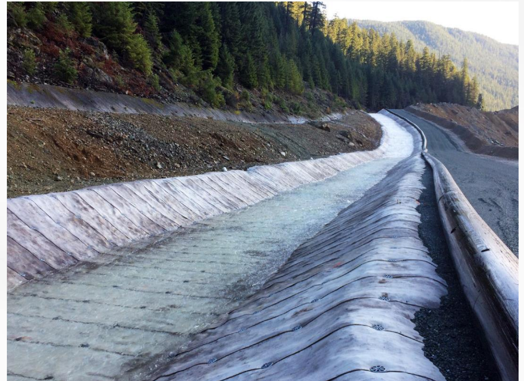
Recubrimiento de Canales, Aplicación típica de GCCM Tipo II (Myrafalls, Canada, 2016)
