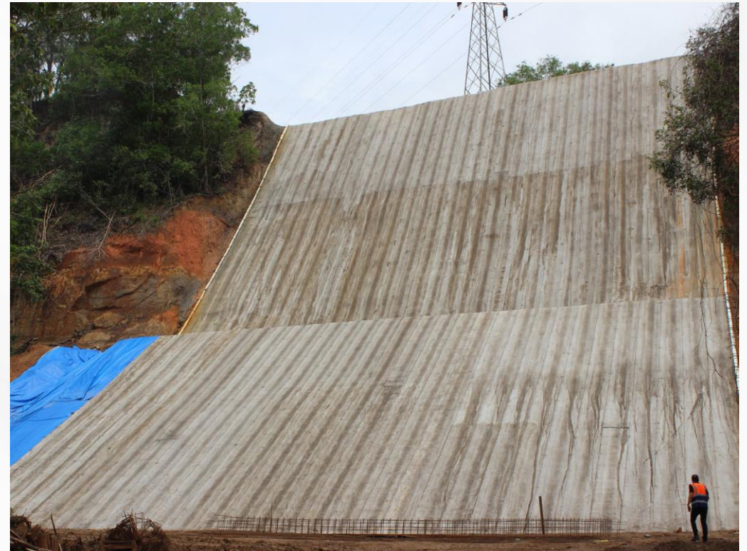
Protección Contra Erosión Permanente en Taludes, Aplicación típica de GCCM Tipo I (Brunei, 2009)
