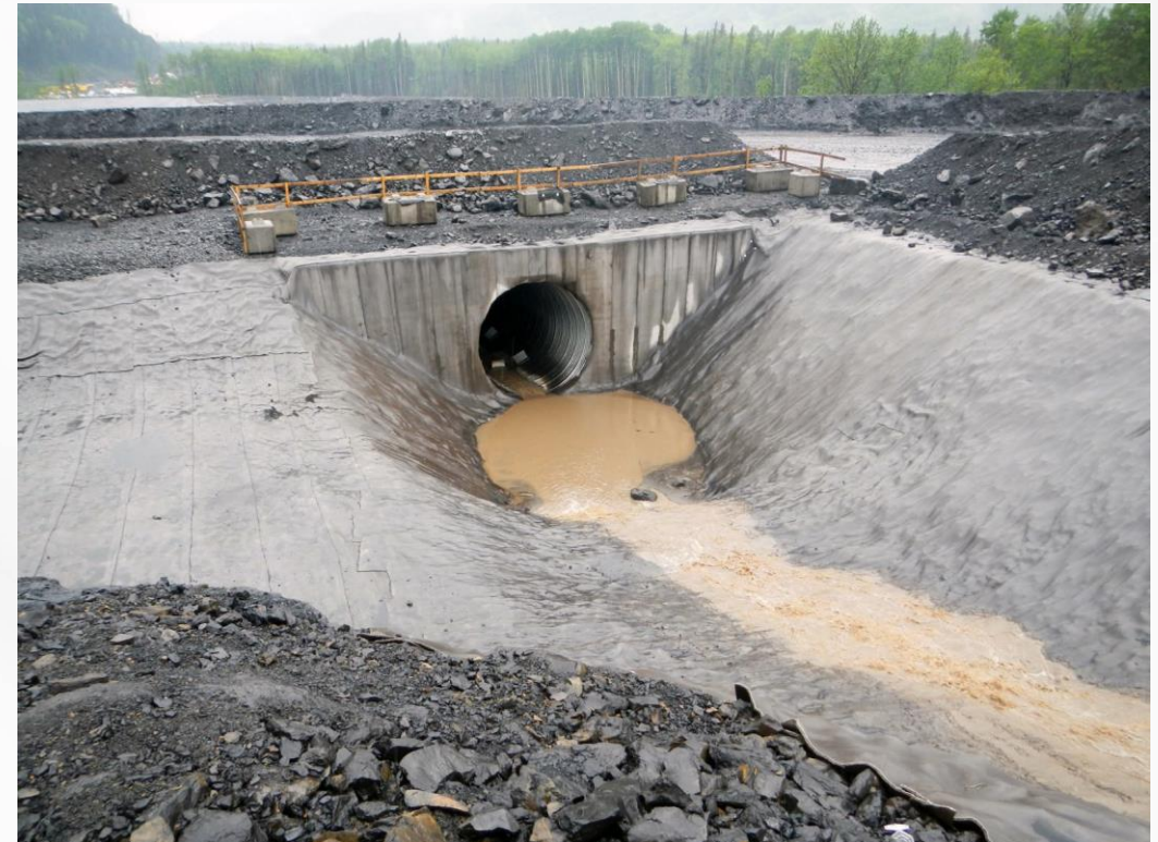
Aplicaciones sobre sustratos poco resistentes y con riesgo de impacto de detritos, Aplicación típica de GCCM Tipo III (Willow, Canada, 2012)
